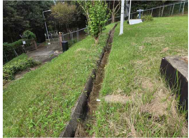
<부대시설 배수로 전경>
