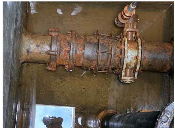
<유출밸브실 1지 하부슬래브 채수>
