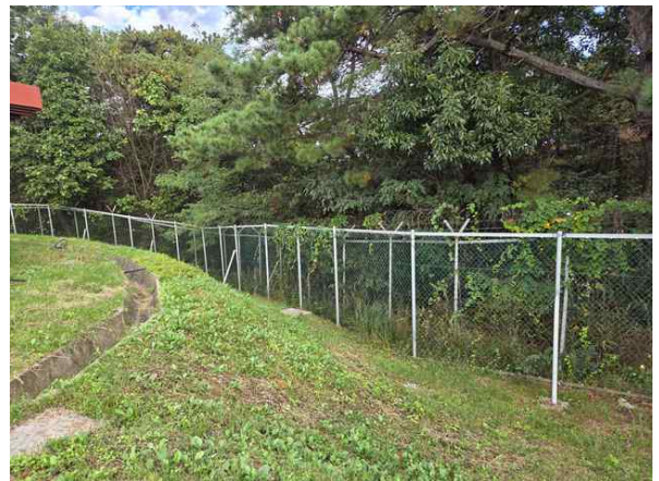
<부대시설 안전펜스 전경>
