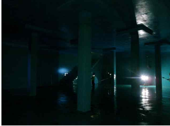
<내부 개별부재 외관조사>
