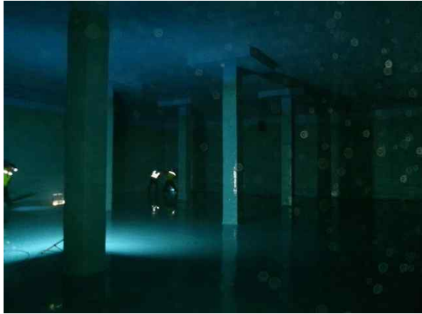
<배수지 1지 전경>
