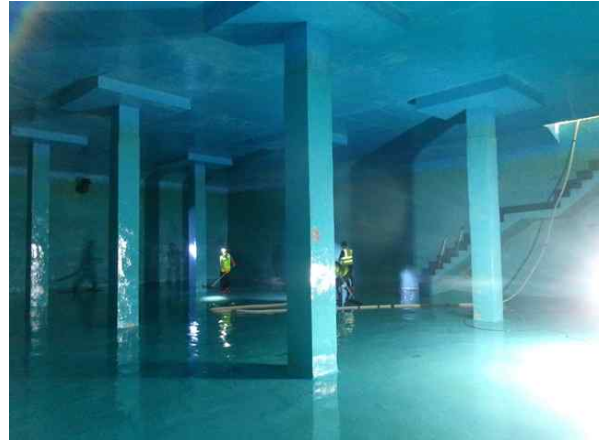
<배수지 2지 전경>
