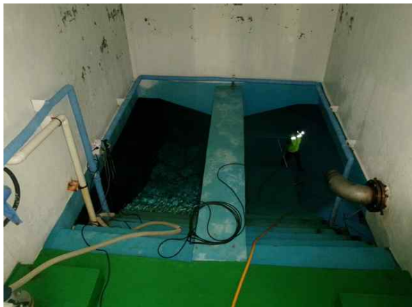
<건축동 내부 전경>
